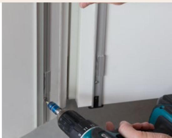
\* 1. Phase de construction - seuls les rails de fixation sont montés
